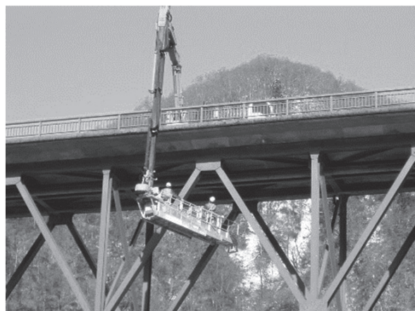
図1 橋梁点検風景
